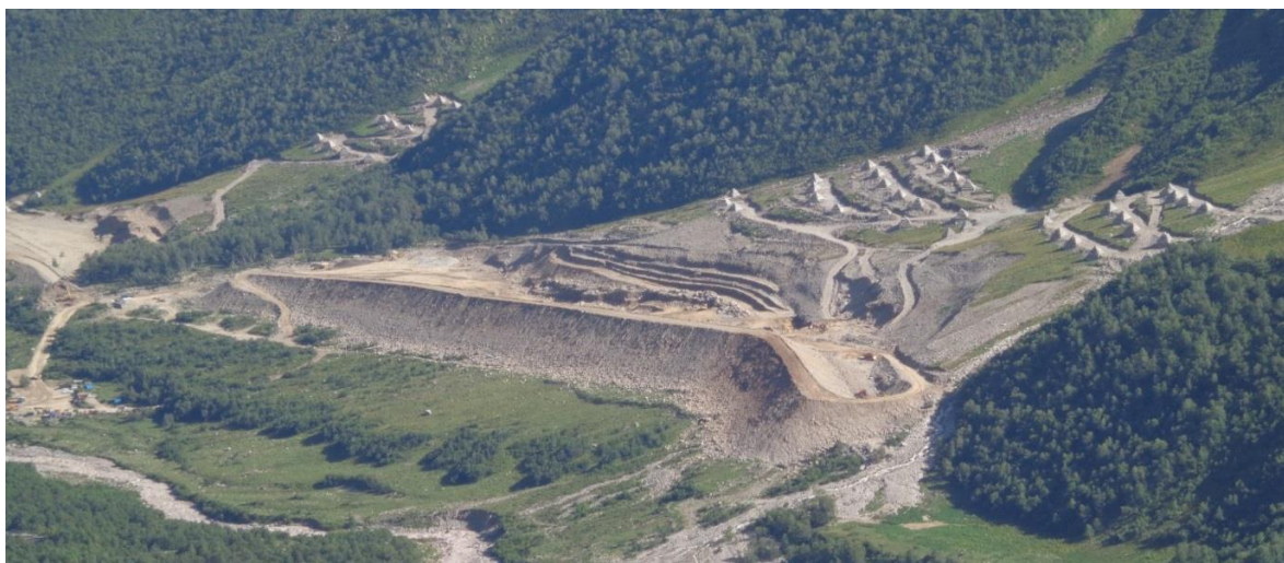
Рис. 23. Общий вид комплекса лавиноотводящих сооружений. Очаги № 9, 10.
