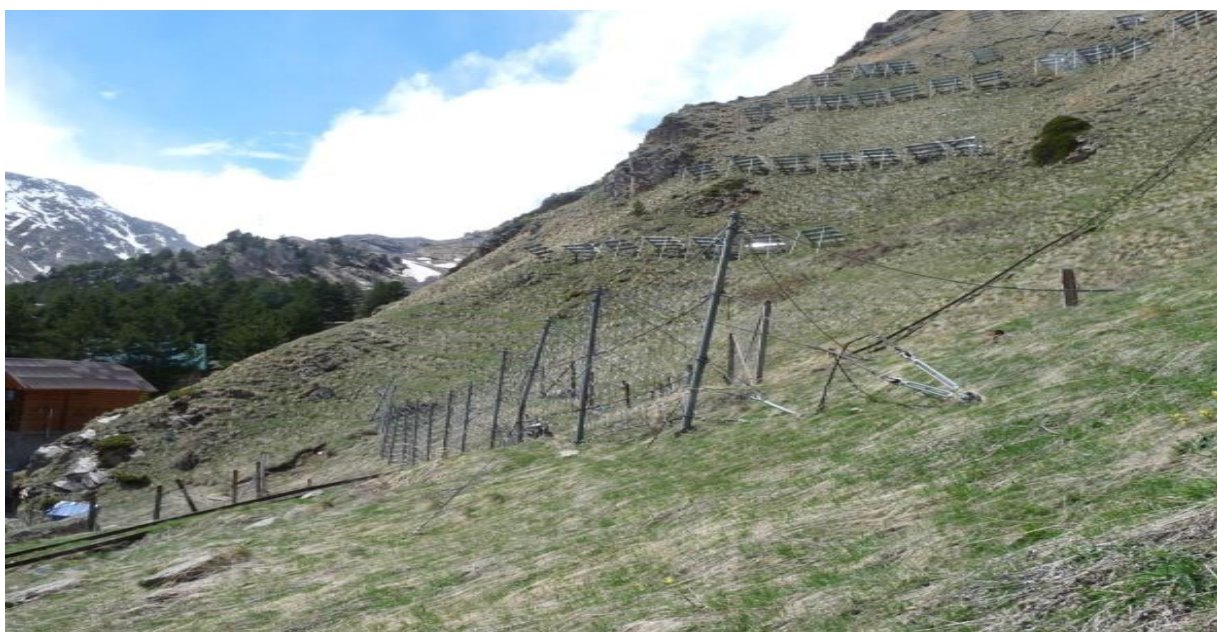
Рис 19. Очаг № 5. Камне- и лавинно- удерживающая сетка, снегоудерживающие щиты и конструкции.
