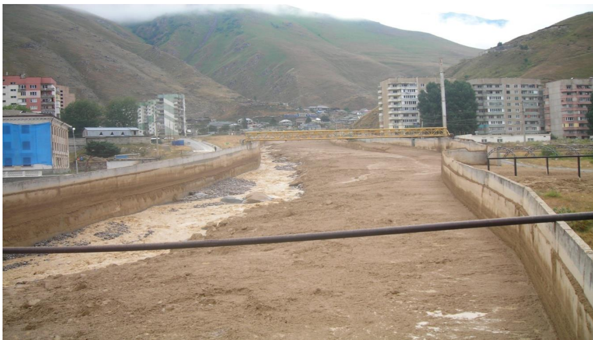
Рис. 26. Отложения селевого потока 14 августа 2017 г. р. Герхожан-Су, селевой лоток в г. Тырнауз
