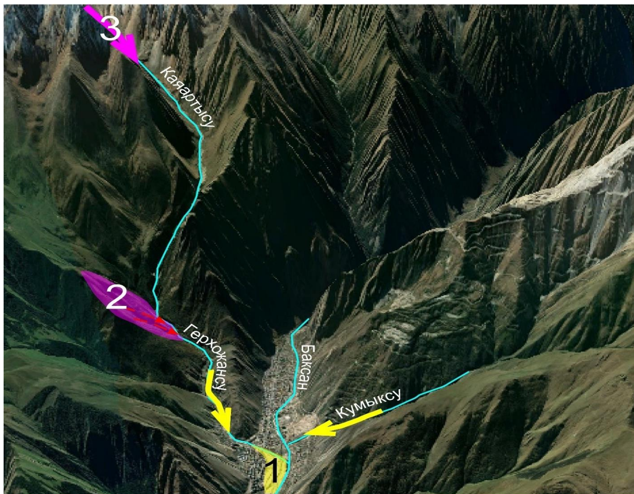
Рис. 25. Город Тырныауз в поле воздействия селей. Цифрами показаны: 1 – выплеск селей по руслу р. Герхожан-Су, 2 – оползень Бузулган, 3 – верховья селесборного очага вблизи ледника.
