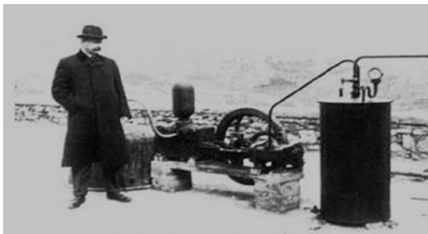
Рис. 1.1. П. Конти и устройство, использованное в первом в мире эксперименте по производству электроэнергии из геотермального пара (Лардерелло, 1904 г.) [140]
