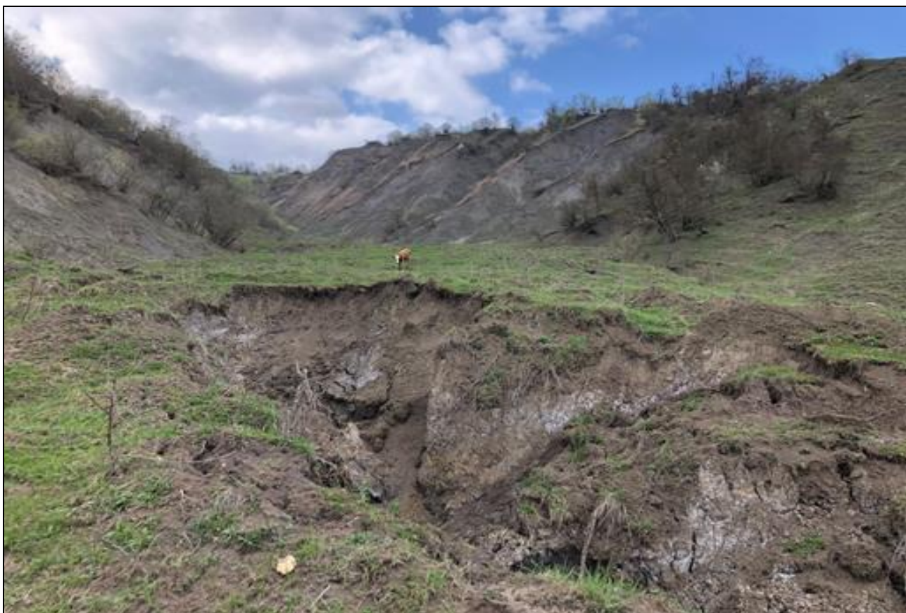
Рисунок 44. Вторичный эрозионный врез в оползневую массу на конусе выноса (с. Белгатой, фото автора, апрель 2022 г.)
